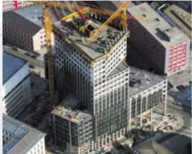
Rohbauherstellung des obersten Bürogeschosses, 24. Obergeschoss • Building the shell for the top office floor on the 24 th level
