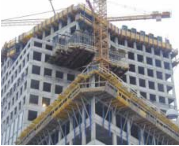
Gebäudeauskragung vom 15. bis 19. Stockwerk • Cantilevering unit between the 15 th and 19 th floors
