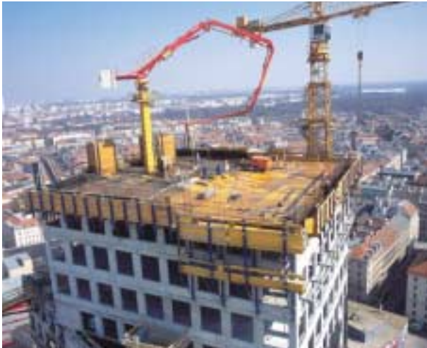
Herstellung des 23. Obergeschosses mit Blick über Wien • Construction of the 23 rd floor overlooking the city
