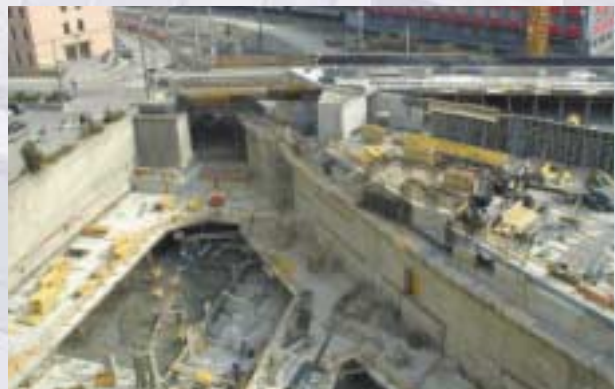
Deckelbauweise • Top-down method
