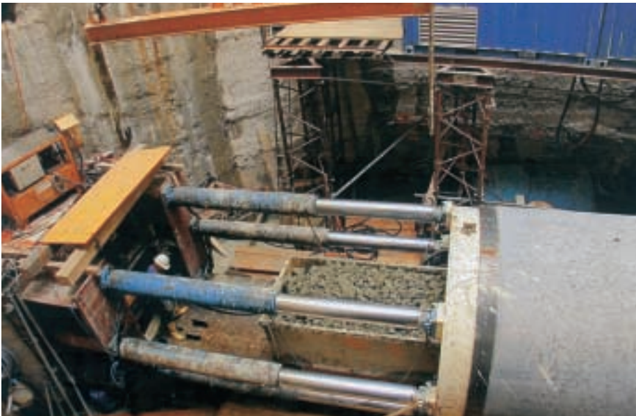
Hauptpress-Station im Startschacht
