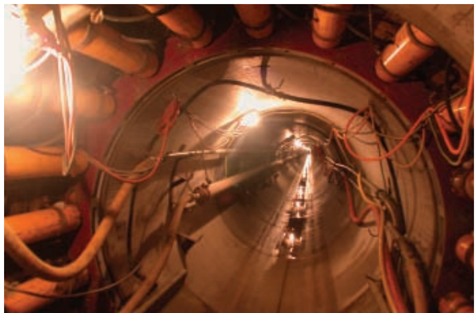
Zwischenpress-Station
