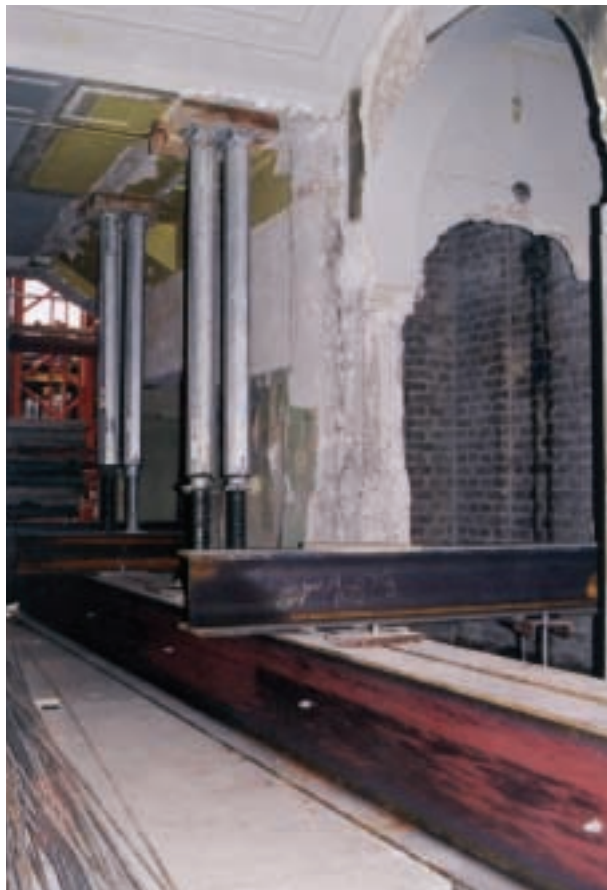
Lastabfangung und alter Aufzugskern
