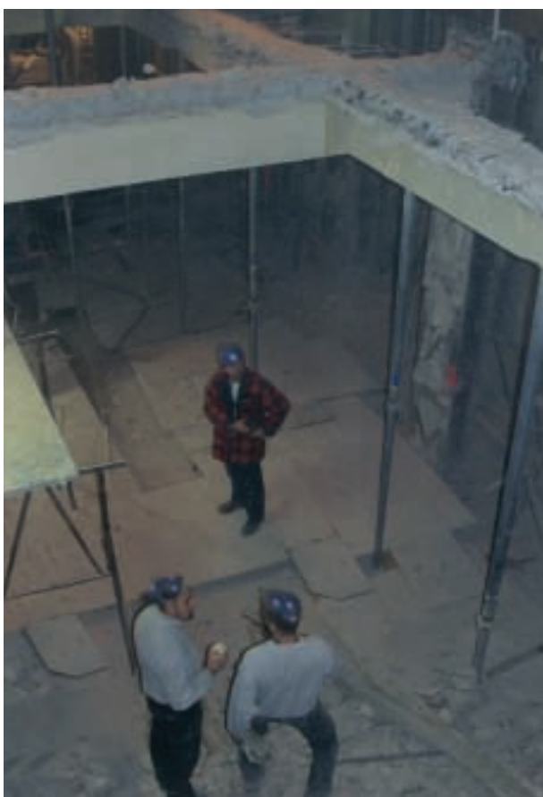
Abbruch der Decke über dem Erdgeschoss
